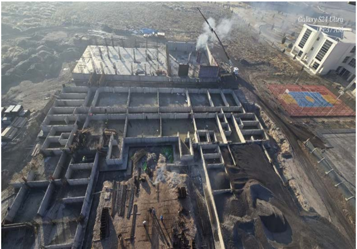
Resim 2.Tıp Fakültesi Morfoloji Binası İnşaata 2
