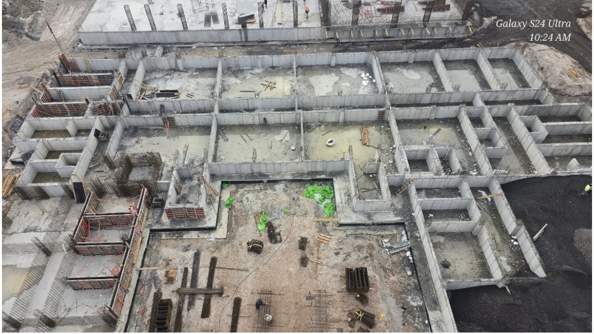
Resim 1.Tıp Fakültesi Morfoloji Binası İnşaata 1
